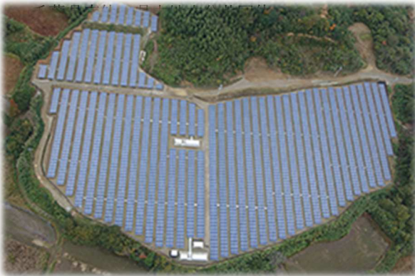
● 潮来新宮太陽光発電所設置工事
